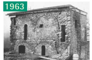
Stenshoffturm (Romanisches Haus) bei der Freilegung
