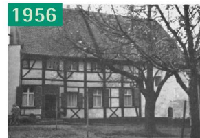
Stenshof mit eingebautem Turm (rechts)
